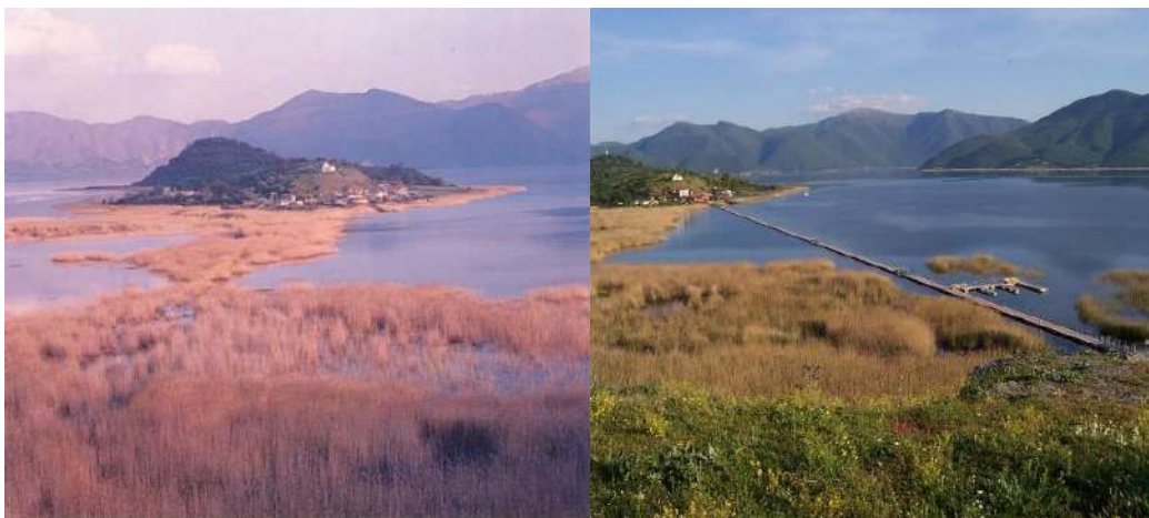
Εικόνα 7. Πριν και μετά την κατασκευή της πεζογέφυρας του Αγίου Αχιλλείου
