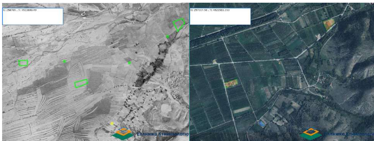
Εικόνα 5: Διάσπαρτη δόμηση στον κάμπο του Λαιμού ανάμεσα στα χωράφια. Αεροφωτογραφία της ΓΥΣ από το 1945 στα αριστερά και η ίδια περιοχή το 2015. Πηγή: Ελληνικό Κτηματολόγιο
