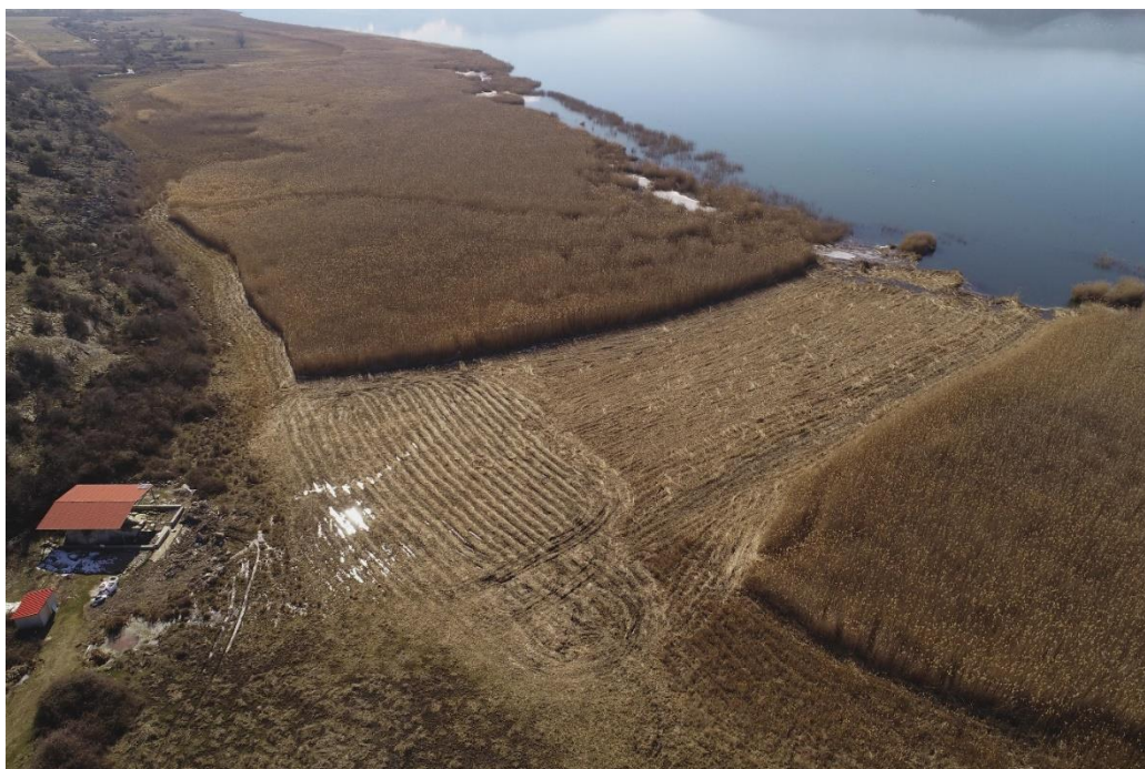
Εικόνα 6. Αντιπυρική ζώνη στην περιοχή του βυζαντινού μνημείου της Αγίας Άννας, που βρίσκεται στην περιοχή Λευκώνας Βόρεια - Αγία Άννα (φωτ. Ο. Αλεξάνδρου)
