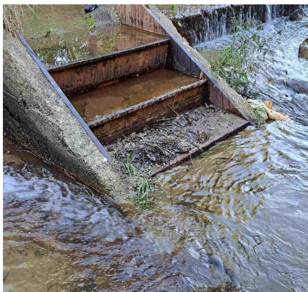
Φωτογραφία 4.2.4 Ιρλανδική διάβαση 2. Διακρίνεται η υφιστάμενη ιχθυόσκαλα. Θέα προς ανάντη (αρχείο ΕΠΠ, 2024).
