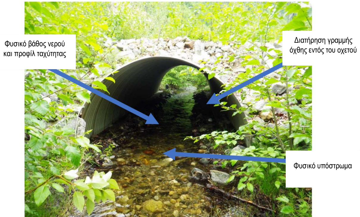
Σχήμα 5.2.3 Παράδειγμα μη εγκιβωτισμένου μεταλλικού οχετού μεγάλης διαμέτρου, του οποίου το 1/3 πληρούται με φυσικά υλικά κοίτης (μετάφραση από Franklin et al., 2018).
