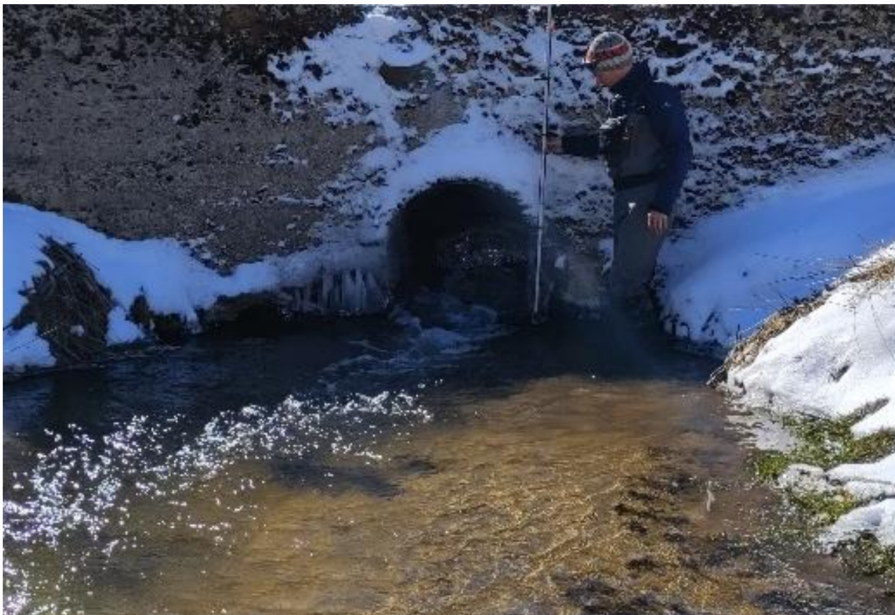
Φωτογραφία 4.2.38 Έξοδος σωληνωτού οχετού (Θέα προς ανάντη) (Caudron & Vigier, 2025).
