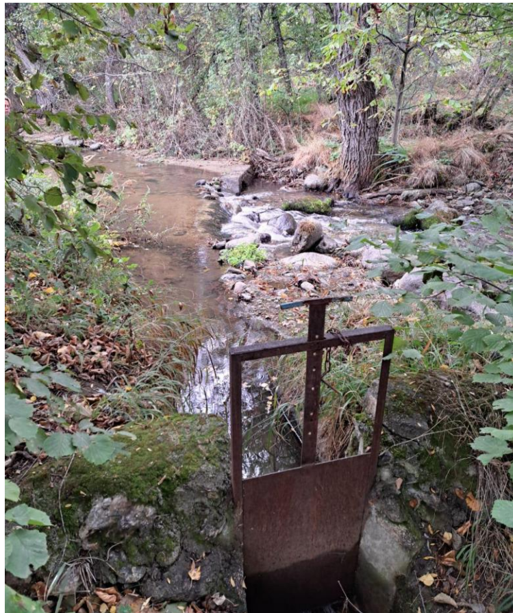
Φωτογραφία 4.2.7 Λιθόκτιστος αναβαθμός εγκάρσια στη διεύθυνση ροής και μεταλλικό θυρόφραγμα πλευρικής υδροληψίας (Χαμηλή παροχή) (αρχείο ΕΠΠ, 2024)
