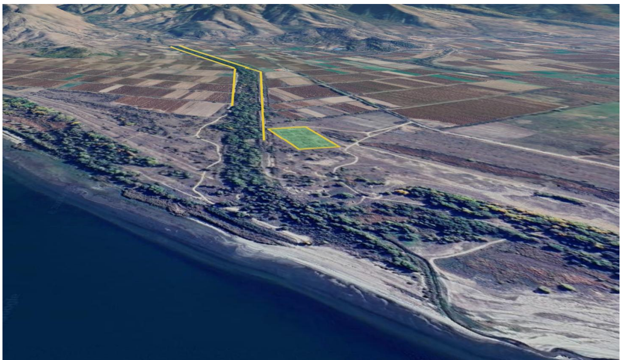
Σχήμα 4.2.3 Γενική άποψη περιοχής πεδινού τμήματος και εκβολών π. Αγ. Γερμανού. Σημειώνονται τα αντιπλημμυρικά αναχώματα και η θέση της ΕΕΛ των οικισμών Αγ. Γερμανού και Λαιμού.
