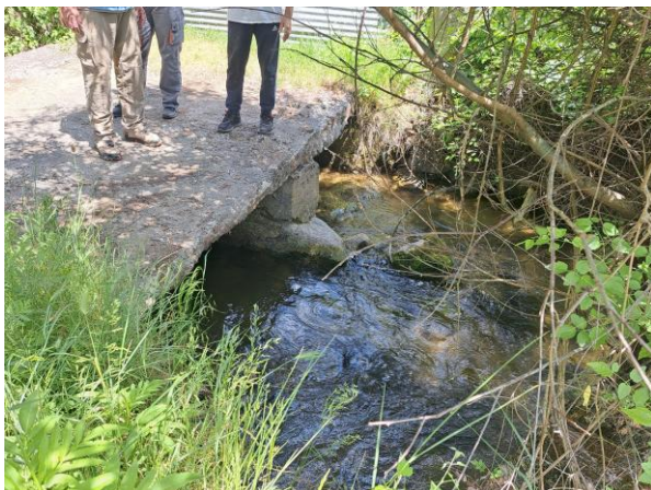
Φωτογραφία 4.2.9 Κατάντη όψη χαμηλής γέφυρας (αρχείο ΕΠΠ, 2024)
