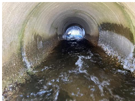
Φωτογραφία 4.2.39 Εσωτερικό σωληνωτού οχετού. Διακρίνεται ο καταβαθμός. Θέα προς καπάνη. (Caudron & Vigier, 2025).
