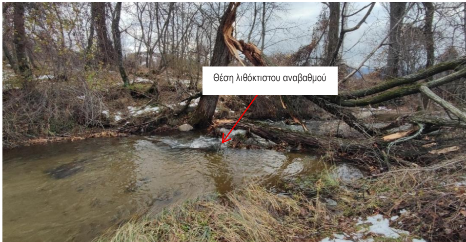
Φωτογραφία 4.2.6 Λιθόκτιστος αναβαθμός εγκάρσια στη διεύθυνση ροής (θέα προς κατάντη, υψηλή παροχή) (αρχείο ΕΠΠ, 2024)
