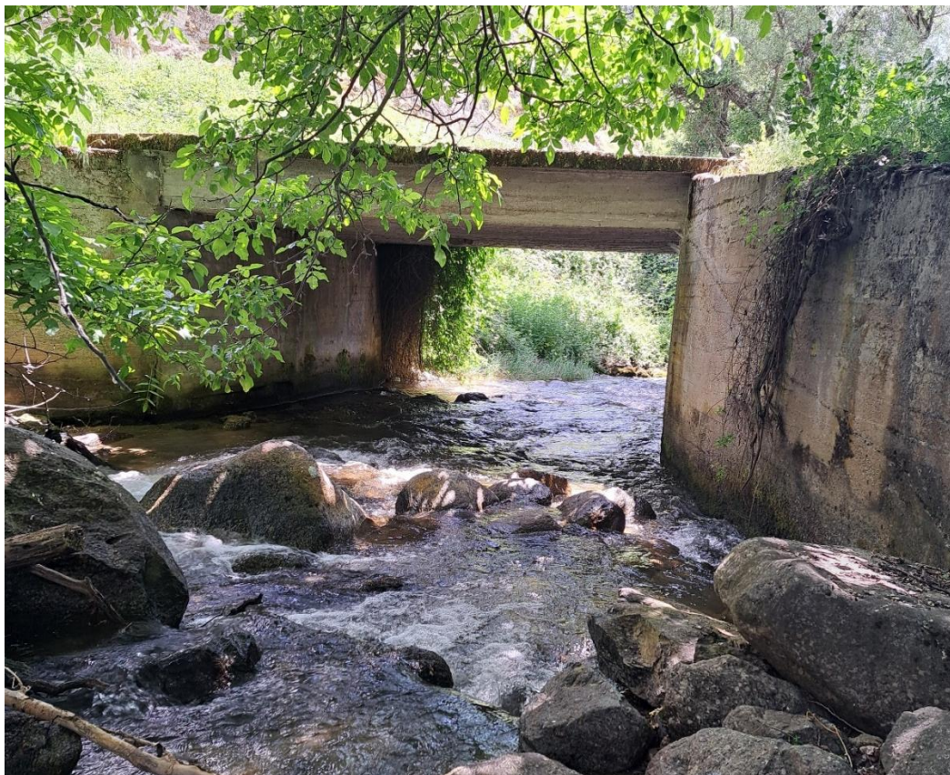
Φωτογραφία 4.2.11 Γέφυρα «Πετρόπουλου», ενός ανοίγματος. Θέα προς κατάντη (αρχείο ΕΠΠ, 2024).
