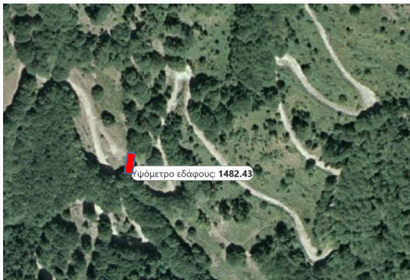
Φωτογραφία 4.2.40 Γενική άποψη περιοχής έργου.
