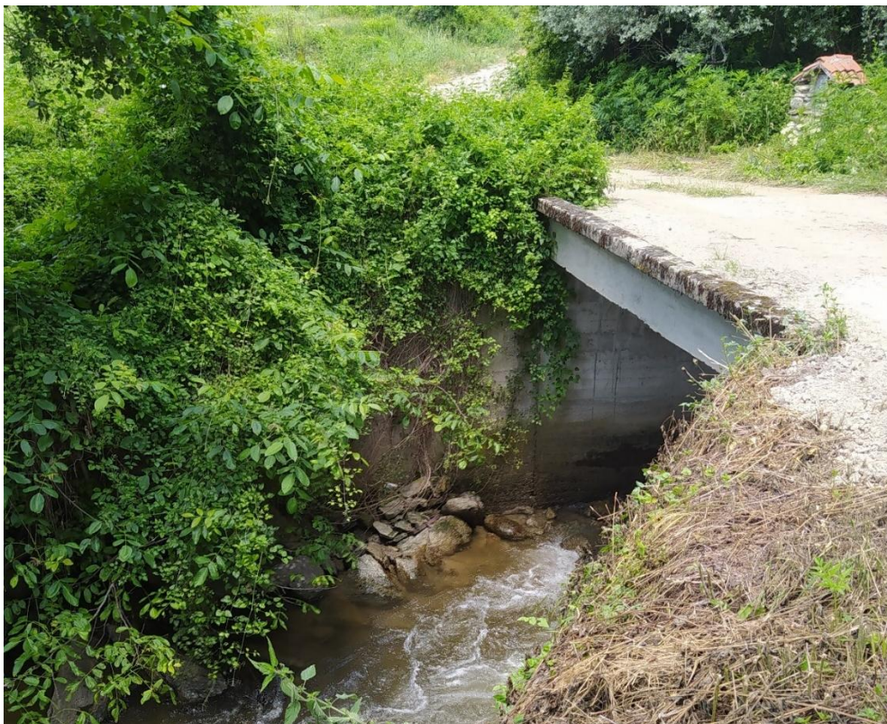
Φωτογραφία 4.2.8 Γέφυρα ενός ανοίγματος πλησίον νερόμυλου Αγίου Γερμανού (θέα προς ανάντη) (αρχείο ΕΠΠ, 2024).
