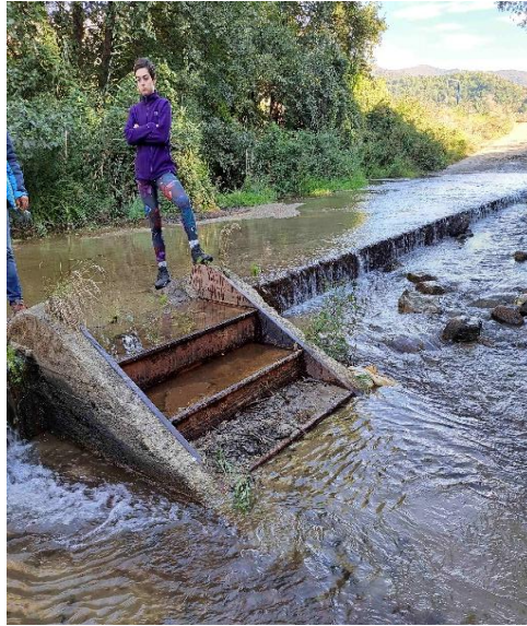
Φωτογραφία 4.2.5 Λεπτομέρεια υφιστάμενης ιχθυόσκαλας. Είναι εμφανής η ανεπάρκεια του σχεδιασμού και της λειτουργίας της (αρχείο ΕΠΠ, 2024).
