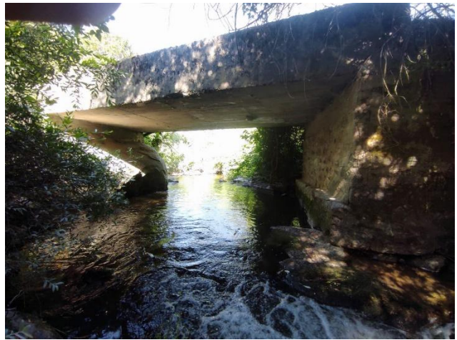
Φωτογραφία 4.2.24 Άποψη γέφυρας (λήψη από την κοίτη, θέα προς κατάντη).
