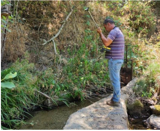
Φωτογραφία 4.2.14 Είσοδος αρδευτικής διώρυγας. Διακρίνεται η μεταλλική θύρα ελέγχου της ροής. (αρχείο ΕΠΠ, 2024).
