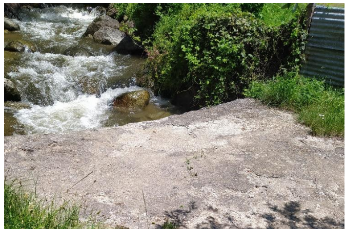
Φωτογραφία 4.2.10 Κατάστρωμα γέφυρας (θέα προς ανάντη) (αρχείο ΕΠΠ, 2024)
