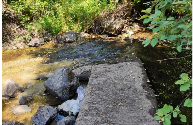
Φωτογραφία 4.2.15 Αναβαθμός σκυροδέματος εγκάρσια στη διεύθυνση ροής και κεκλιμένο επίπεδο (ράμπα) σε τμήμα αυτού προς τη δεξιά όχθη. (αρχείο ΕΠΠ, 2024).
