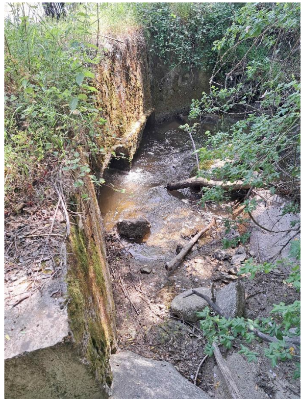
Φωτογραφία 4.2.29 Κατάντη όψη οχετού. Θέα προς ανάντη (αρχείο ΕΠΠ, 2024).
