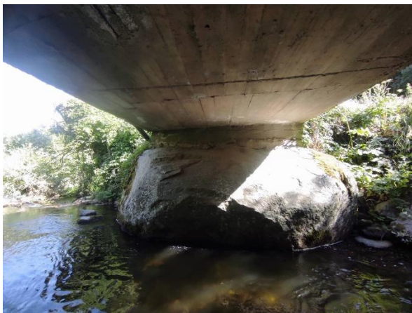
Φωτογραφία 4.2.25 Άποψη κοίτης κάτωθεν γέφυρας (θέα προς αριστερό αντέρεισμα).
