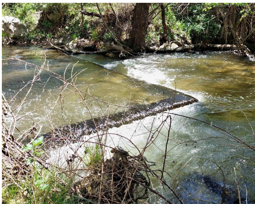
Φωτογραφία 4.2.21 Λεκάνη ηρεμίας κατάντη κεκλιμένου επιπέδου εντός της κυρίως κοίτης του ρέματος (αρχείο ΕΠΠ, 2024) (αρχείο ΕΠΠ, 2024).
