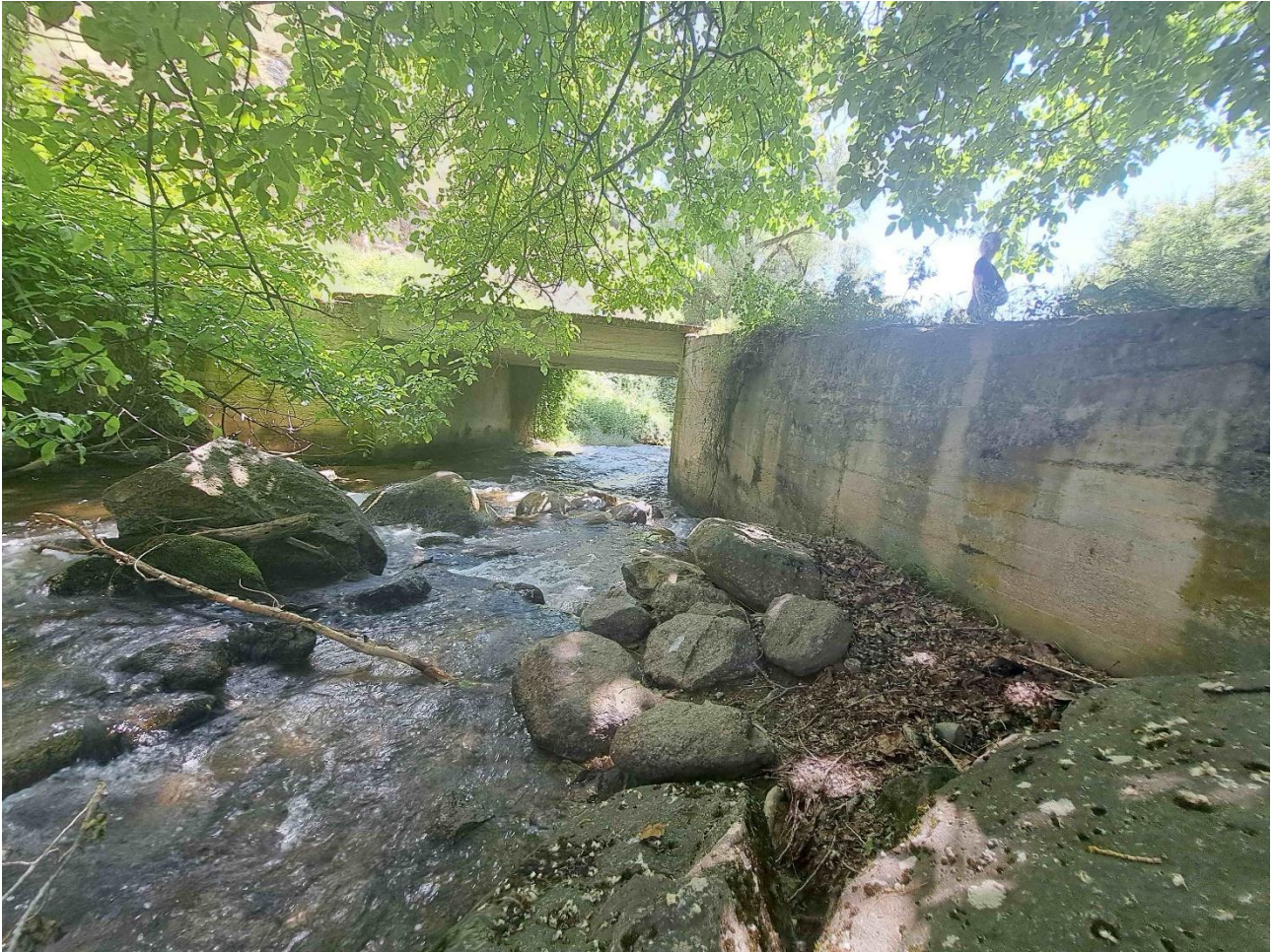
Φωτογραφία 4.2.12 Γέφυρα «Πετρόπουλου», ενός ανοίγματος. Διακρίνεται το επίμηκες τοίχιο από σκυρόδεμα στη δεξιά όχθη. Θέα προς καπάντη (αρχείο ΕΠΠ, 2024).
