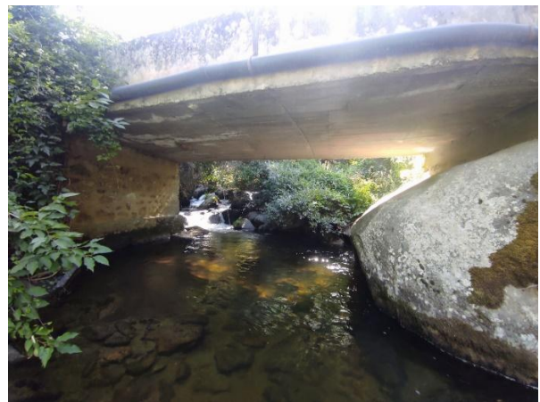
Φωτογραφία 4.2.26 Άποψη γέφυρας (λήψη από την κοίτη, θέα προς ανάντη).
